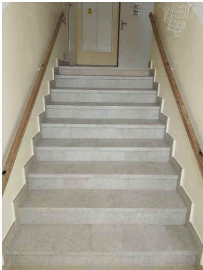
Nové schodiště v budově Základní školy
